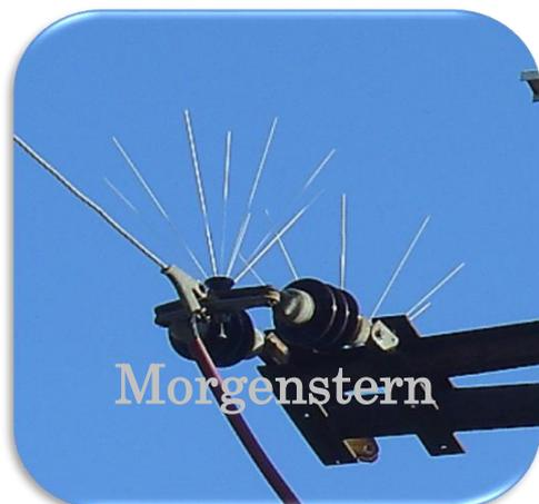
**9 Stäbe aus nichtleitendem Material, witterungs und UV-beständig, GFK Stab 500mm**
