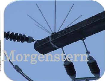
**9 Stäbe aus nichtleitendem Material, witterungs und UV-beständig, GFK Stab 500mm**
